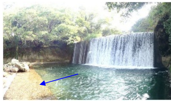
前庭保護工状況
