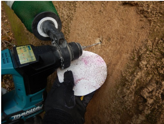
写-1 中性化試験状況(例)
