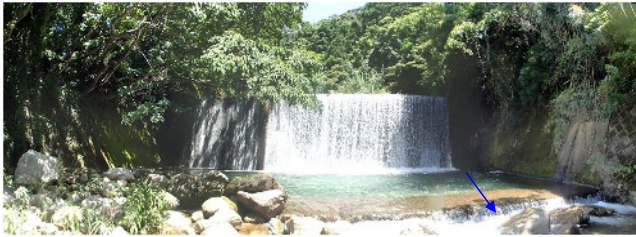
堰堤上流状況
