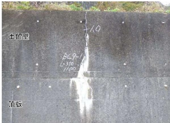
漏水・遊離石灰状況(頂版, 土留壁)
