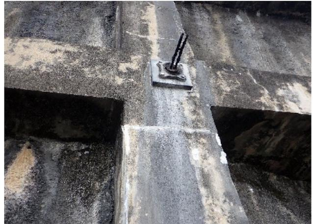
頭部キャップの脱落・腐食状況
