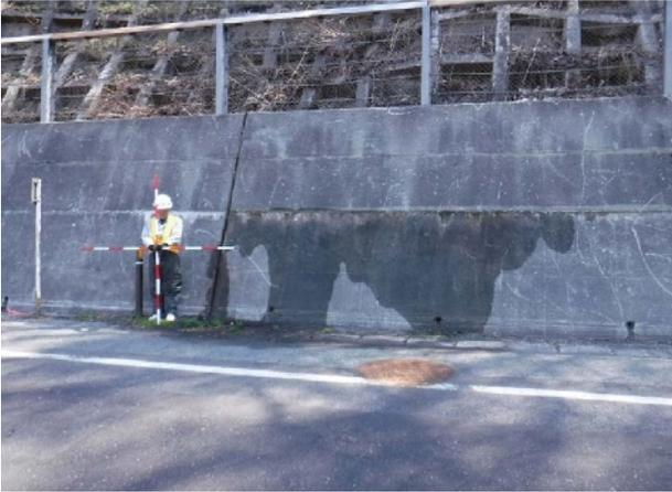
打ち継目からの漏水状況
