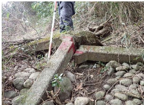
のり枠破損状況
