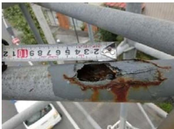
腐食・断面欠損状況
