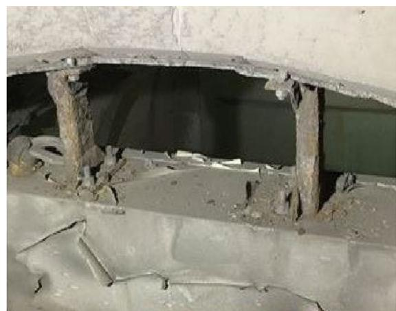
取付部材の腐食状況
