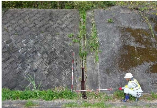
擁壁の移動による縦排水の閉塞状況
