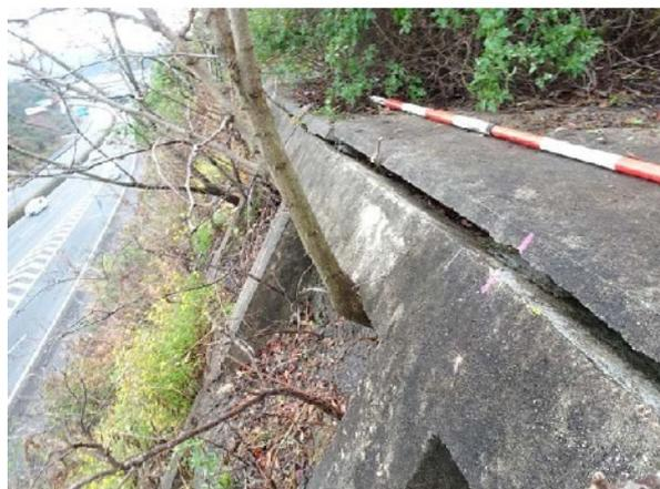
のり面移動による隙間状況
