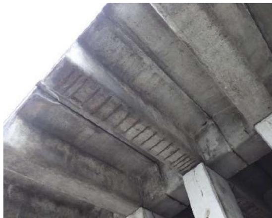
鉄筋露出状況(主桁)
