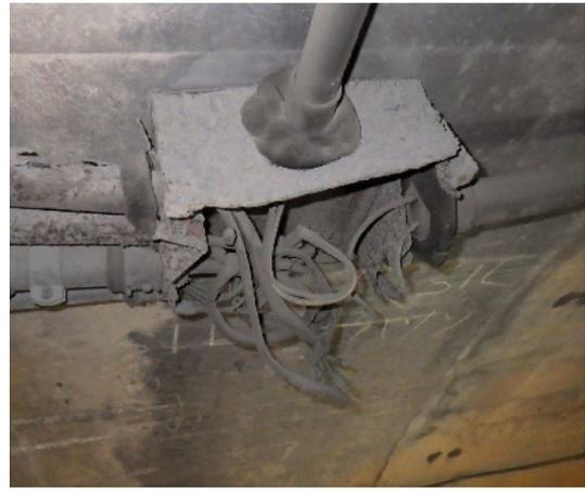
電配ケーブルBOX欠損状況
