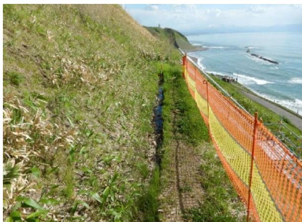
土砂堆積, 滞水状況
