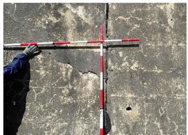
亀裂, 浮き, 剥離状況
