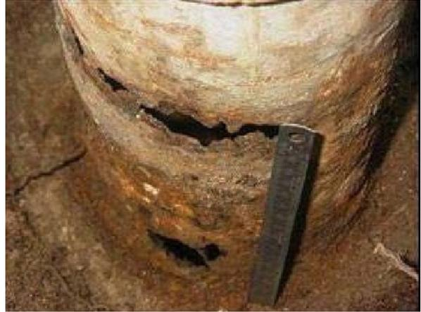
腐食・断面欠損状況
