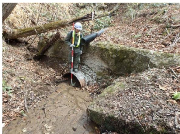
土砂堆積・閉塞状況
