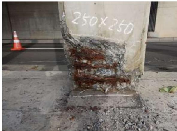
鉄筋露出状況(支柱)
