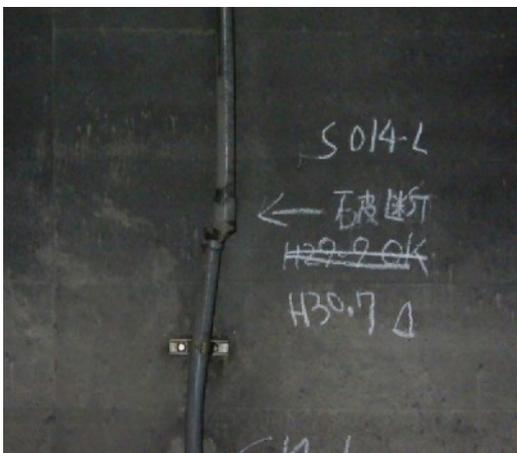
配管の破断状況
