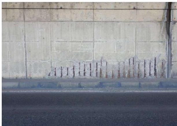
鉄筋露出状況(壁面)
