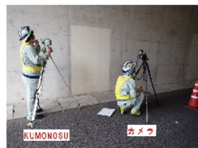
写真 3.7 点検状況 (橋脚 3)
