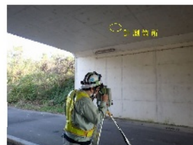
写真 3.7 ひびわれ計測状況 (橋脚 4)
