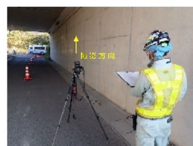
写真 3.8 画像撮影状況 (橋脚 4)
