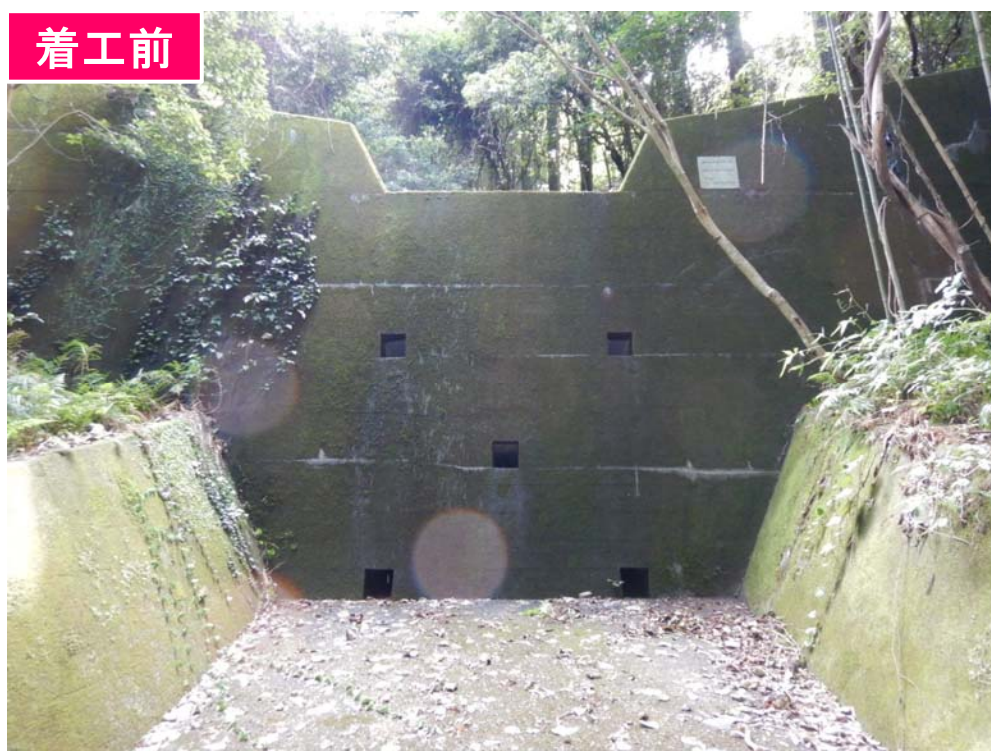
柴内谷 総合流域（緊急改築）工事 令和4年3月完成
