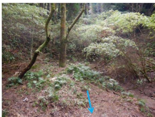
堰堤上流状況
