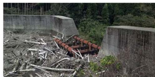
非越流部天端上流端と透過部頂部が一致していない捕捉事例
