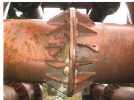
写真2.8 継手部の損傷事例1
