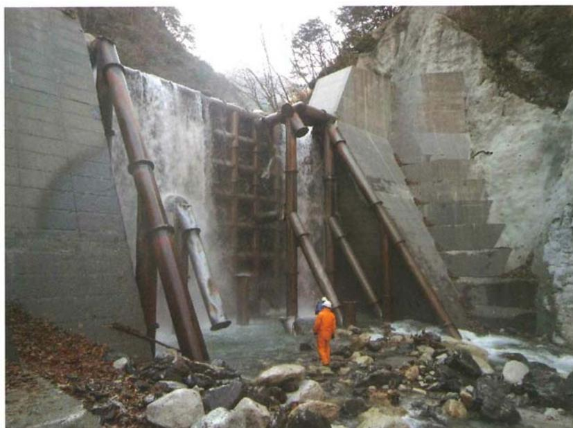
写真2.7 越流礫による部材の喪失
