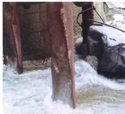
写真2.6 底版近傍の柱根元のへこみ
