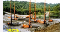
深層混合処理工法
