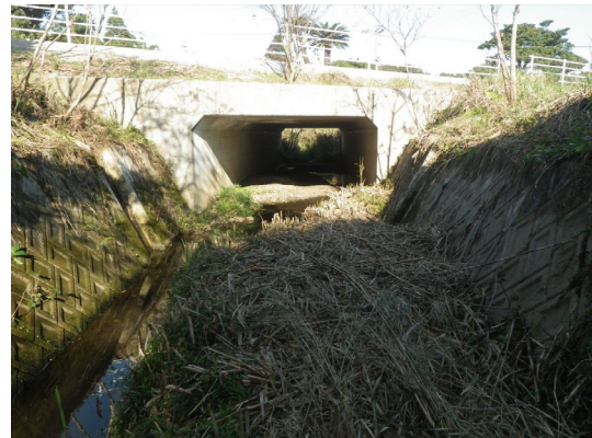
ボックスカルバートによる道路横断
