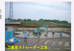
二重管ストレーチャー工法
