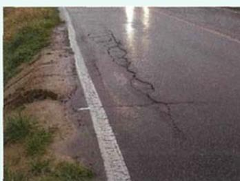
写真 侵食+路面亀裂
