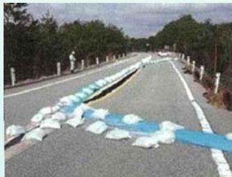
写真 亀裂・段差
