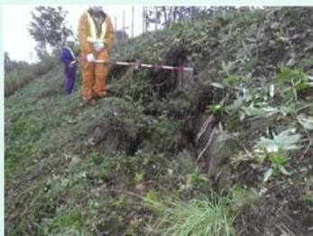
写真 亀裂及び段差
