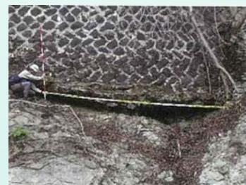
写真 洗掘による空洞
