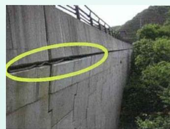
写真 防護柵基礎の傾斜
