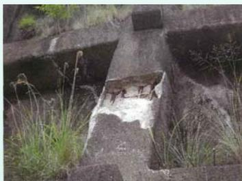
写真 剥離及び鉄筋露出
