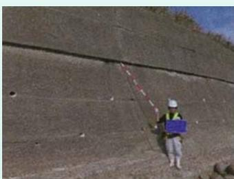
写真 打継ぎ目のずれ
