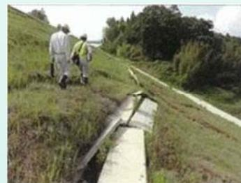
写真 排水施設の損傷
