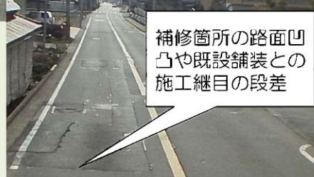
補修箇所の路面による縦断方向の凹凸
