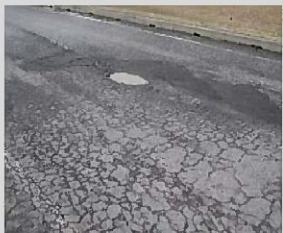
路盤が損傷している状況
