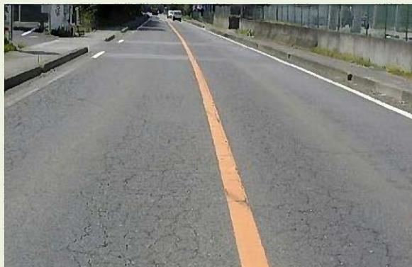
路床・路盤の支持力低下による亀甲状ひび割れの例
