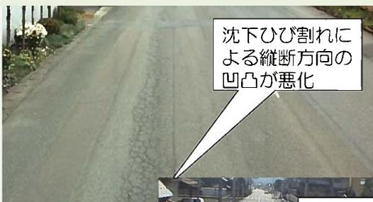
沈下ひび割れによる
