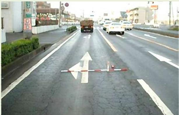
路床・路盤の圧縮変形によるわだち掘れの例
