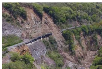
断層変位や斜面崩壊等による橋の倒壊
