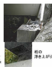
変位制限構造の損傷
