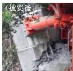
制震ダンパー取付部の損傷
