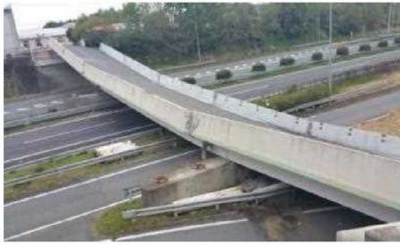
ロッキング橋脚を有する橋の落橋
