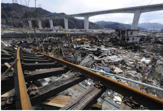
津波による影響を受けないように 桁下高さを確保
