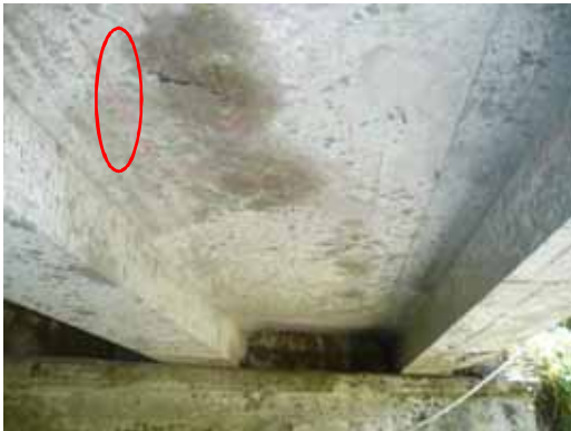
RC床版の鉄筋の腐食により、かぶりコンクリート浮きが見られる。
