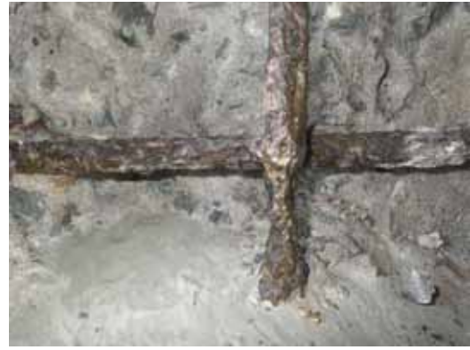
鉄筋の腐食による断面欠損
