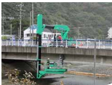
近接目視点検
