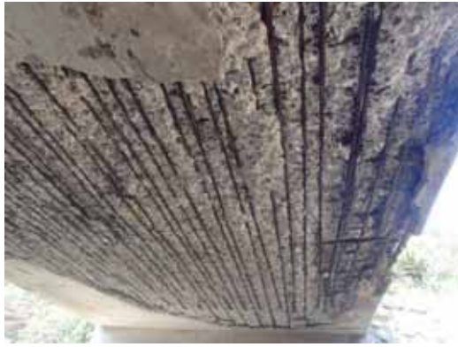
鉄筋の腐食によるかぶりコンクリートの剥離
