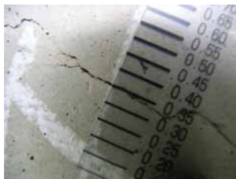
外観調査（ひび割れ幅測定）
