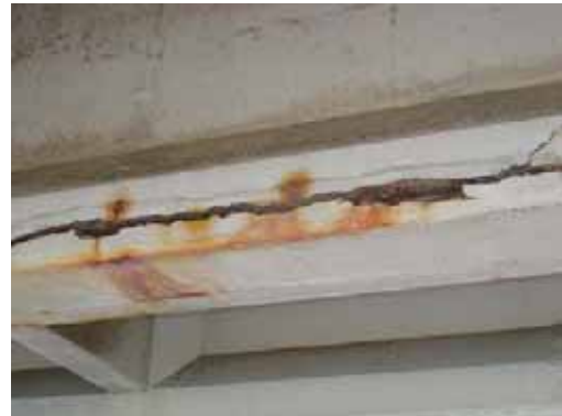
PC桁の軸方向鋼材の腐食に沿ったひび割れ。部分的に鋼材の露出も見られる。
