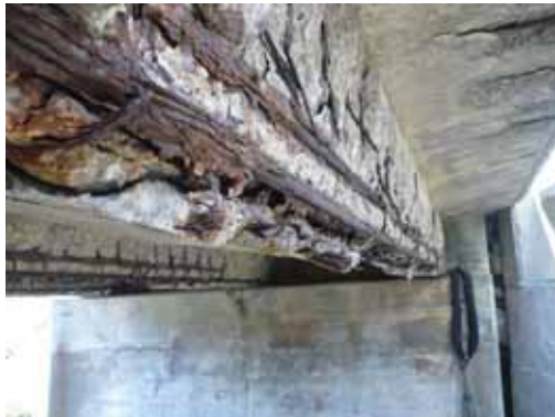
RC桁の鉄筋の著しい腐食により、コンクリートの断面欠損や鉄筋の断面減少、破断が見られる。
