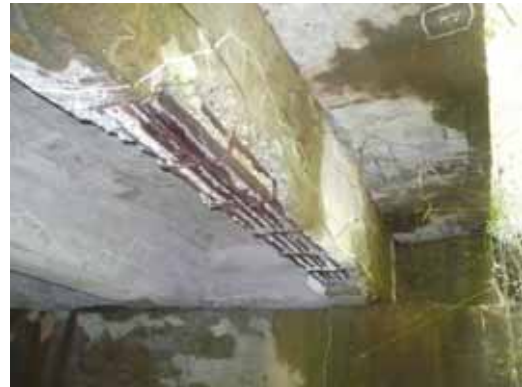
RC桁の鉄筋の著しい腐食により、コンクリートの断面欠損や鉄筋の断面減少が見られる。
