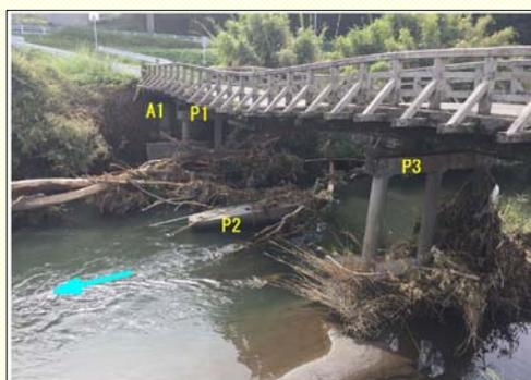
P2橋脚が流出し、上部工(木橋)の2/3以上が変状。よって永久橋への架け替え！！
