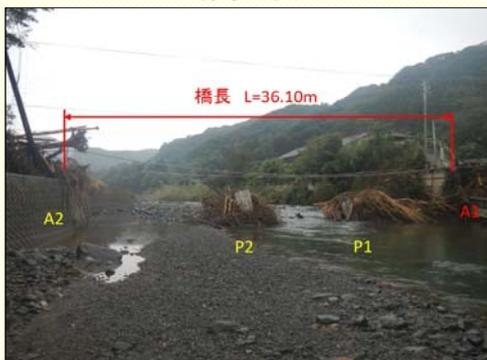
上部工と橋脚は流出したが、橋台の一部が健全。よって部分被災！
