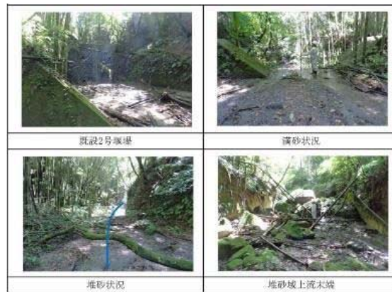
写. 3 既存施設状況
