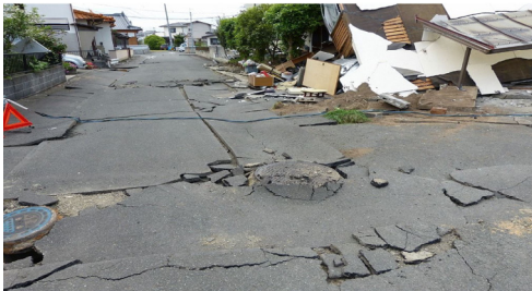
【亀裂 ひび割れ】
