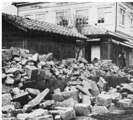
写真2-19 倒壊した鹿児島市内の石塀（左）と地割れができた甲突川の土手（右）
