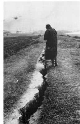
写真2-19 倒壊した鹿児島市内の石塀（左）と地割れができた甲突川の土手（右）
