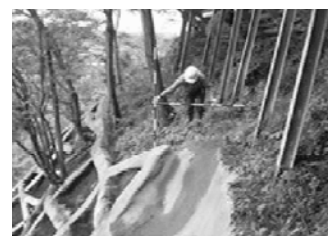
4) 既設対策工のチェック
