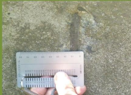
鉄筋直径 :  $\phi$  13mm
