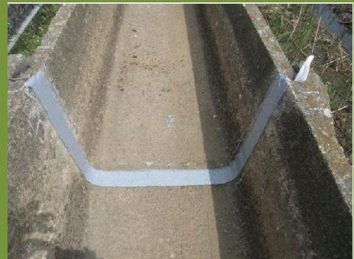
目地の開きが大きい場合には、バックアップ材を開き部分に設置し、シーリング材の塗布を行う。使用する材料や道具は、ホームセンター等で購入できるもので、補修作業についても重機等を使う必要はなく、維持管理の範囲で長寿命化が図れる。
