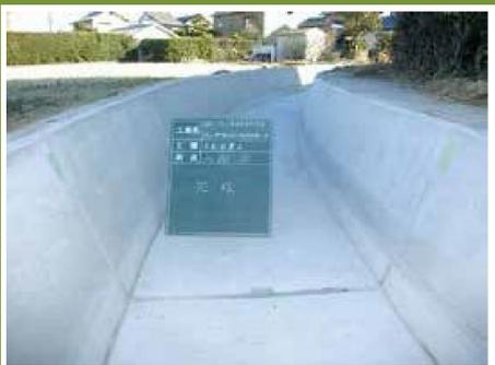
・直射日光や強風により、被覆表面に乾燥ひび割れ等が生じないように、必要に応じてシート養生などを行う。また、冬期施工では、養生時の温度管理を行うとともに、初期凍害を防止するための加温養生を必要に応じて行う。
